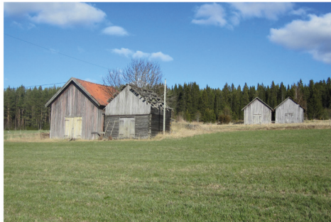
Uthusbyggnader på Ösavägen
