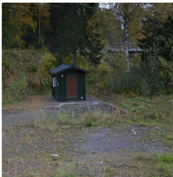
Avloppspumpstation vid Semsån
