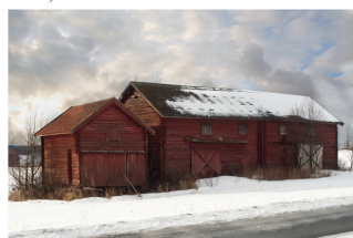
Uthusbyggnad söder om Åsvägen
